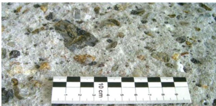
Abb. 12: Klärung des Fräs-/ Strahlbildes als Sanierungsvorbereitung
