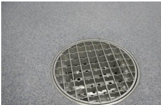
Abb. 4: Detail Bodenabfluss
