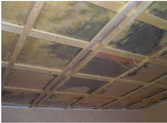
Abb. 3 und 4: Mangel im Rahmen einer energetischen Dachsanierung: Mehr Schimmel als gelbe Dämmwolle
