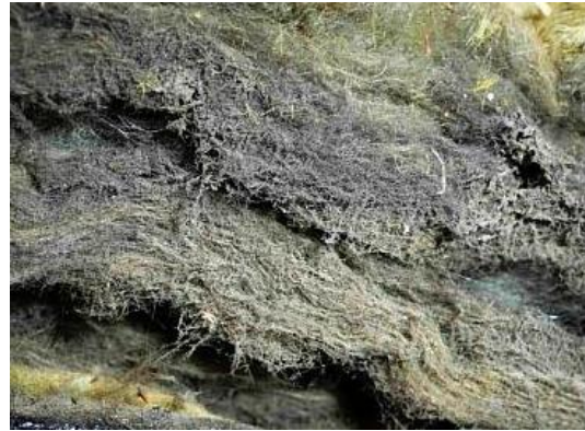
Abb. 3 und 4: Mangel im Rahmen einer energetischen Dachsanierung: Mehr Schimmel als gelbe Dämmwolle
