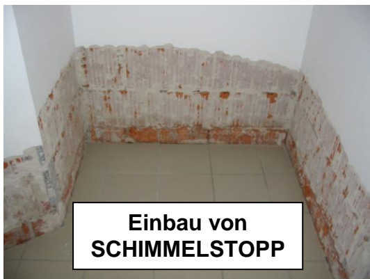
Abb. 4 und 5: Einbau von SCHIMMELSTOPP in die Randfugen einer Arztpraxis nach Wasserschaden und Schimmelbildung in der Fußbodenkonstruktion
