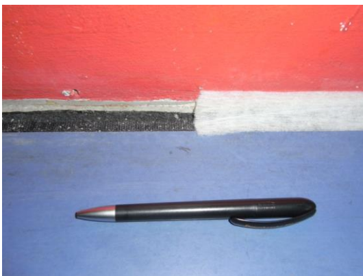
Abb. 6 und 7: Einsatz von SCHIMMELSTOPP in den Randfugen einer Schule, weil diese Maßnahme kurzfristig und schnell umsetzbar war ohne Nutzungsaussetzung des Schulgebäudes
