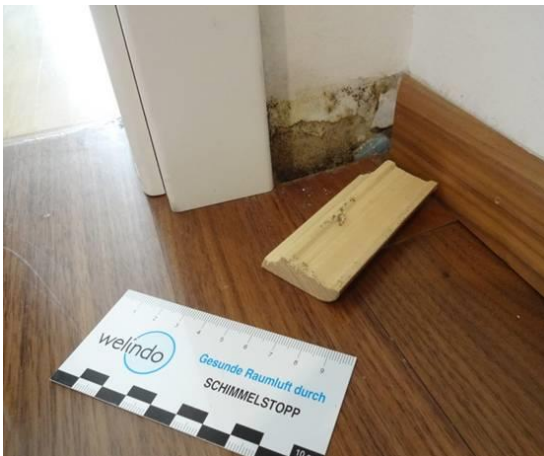
Abb. 6 und 7: Braun-graue bis schwarz-graue Verfärbungen an Wandoberflächen sind auf Schimmelschäden zurückführbar
