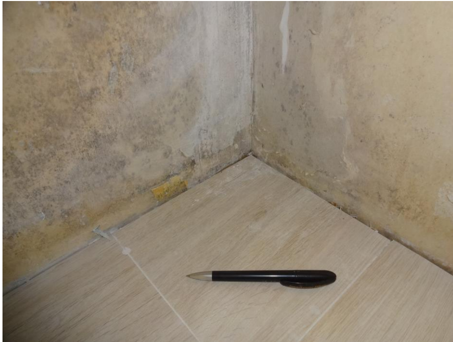
Abb. 2: Grau-schwarze Verfärbungen sind offensichtliche Hinweise für eine sichtbare Schimmelpilzbelastung. Diese sind regelmäßig mit verdeckten, nicht sichtbare Schimmelpilz-/ Bakterienbelastungen vergesellschaftet.
