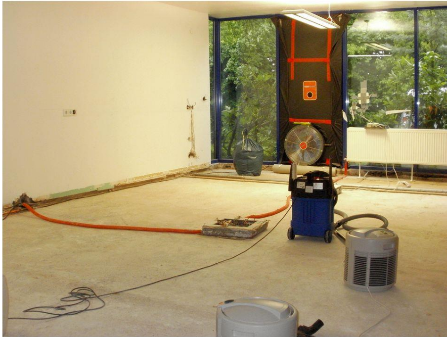
Abb. 8: Sanierung eines Schimmelschadens
