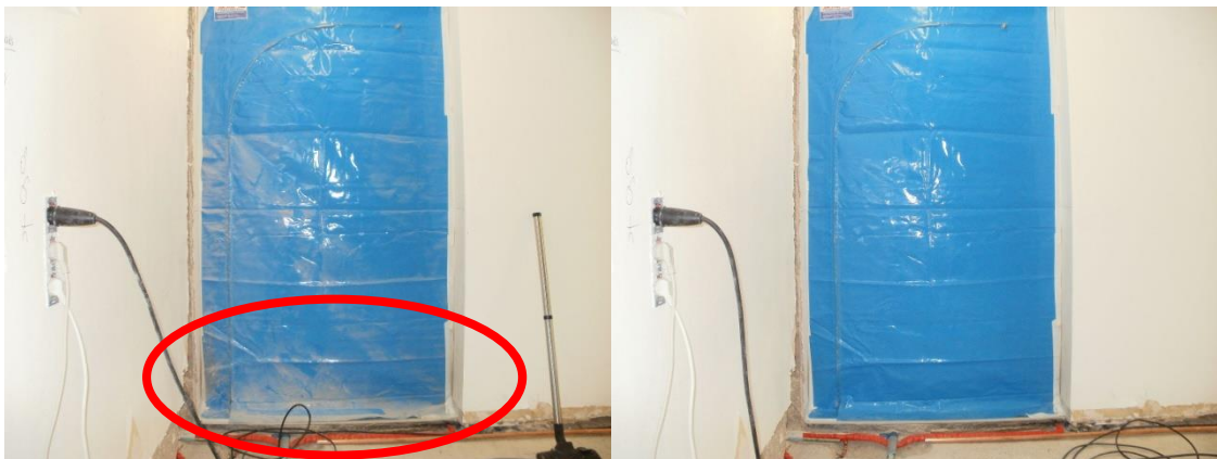
Abb. 9: Vor der Feinreinigung und ... .. nach der Feinreinigung
