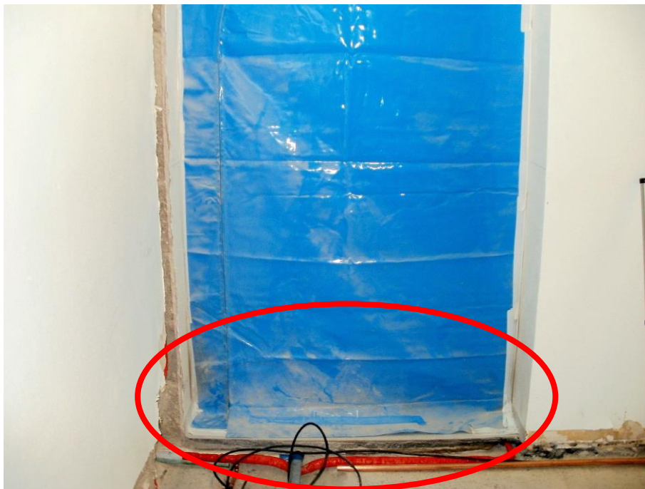
Abb. 2: Extreme Verstaubung einer Staubschutztüre
