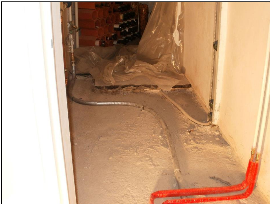
Abb. 4: Extreme Verstaubung nach Rückbau
